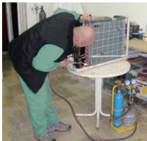
Popravak klime u radionici
