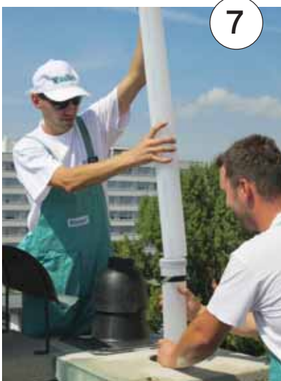
Montaža i spajanje dodatnih produžnih dimovodnih nastavaka s odstojećima
