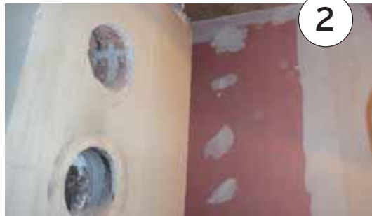
Bušenja otvora na dimnjaku
