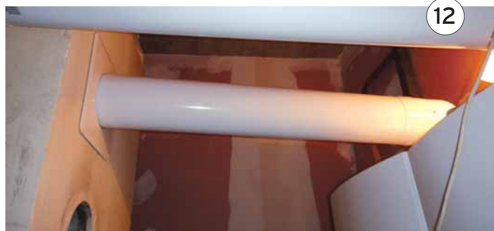
Završna montaža zrako/dimovoda između uređaja i saniranog dimnjaka
