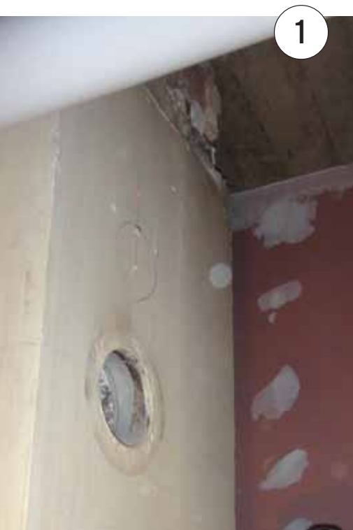
Zacrtaivanje otvora na dimnjaku
