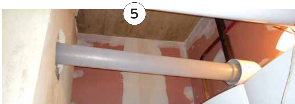
Montaža dimnovodne cijevi između kondenzacijskog uređaja i potpornoga koljena
