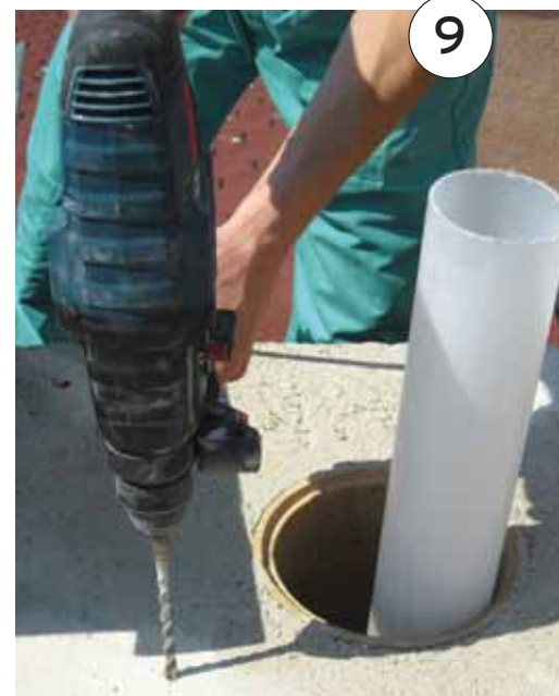
Bušenje rupa za montažu dimovodne kape
