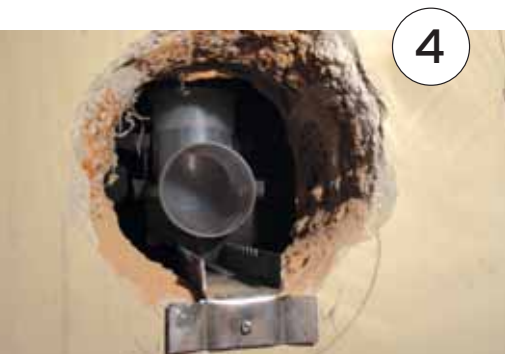
Montaža potpornoga koljena
