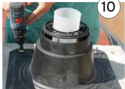
Montaža dimovodne kape
