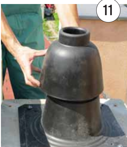
Montaža gornjeg dijela dimovodne kape
