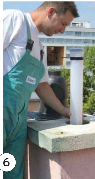
Montaža dimnovodne cijevi s odstojnikom u dimnjak
