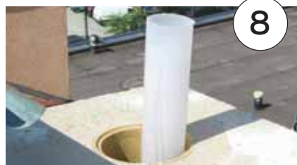
Skraćivanje završnog dimovodnog produžetka
