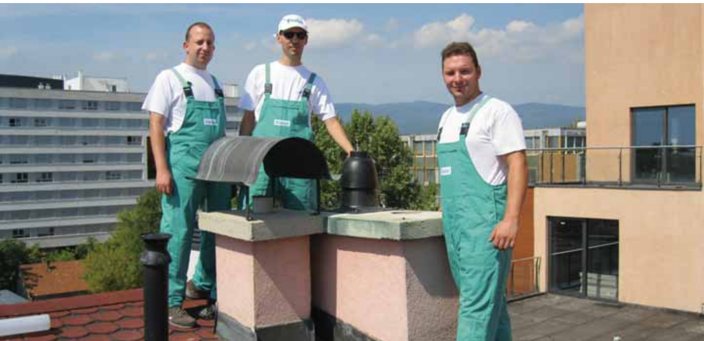
„Instalater“ nakon uspješne sanacije
